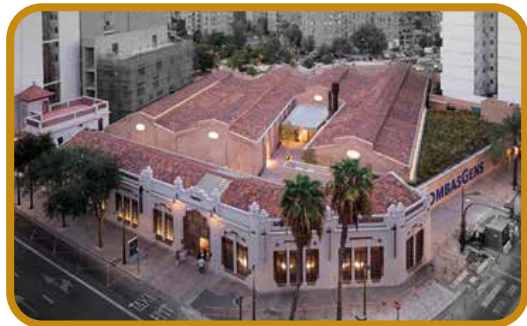
CENTRO CULTURAL BOMBAS GENS (Valencia)
